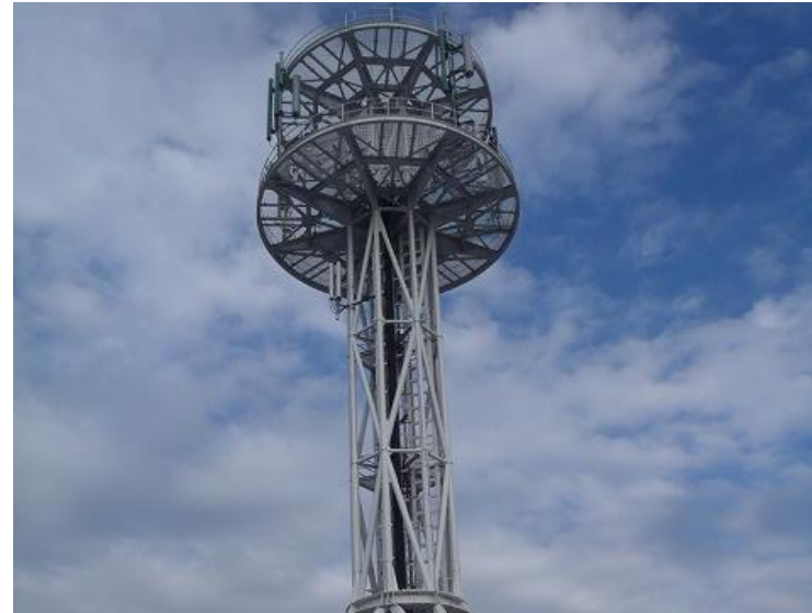
* 通信事業者等からの鉄塔の譲渡
