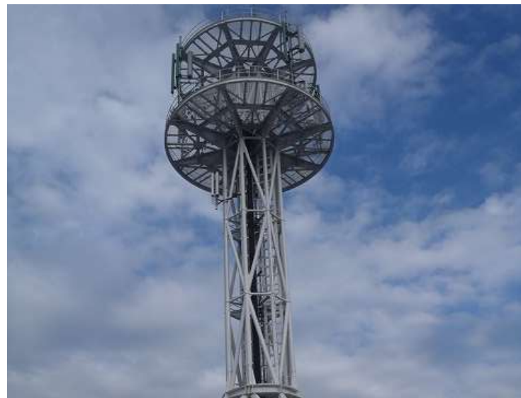
* 通信事業者等からの鉄塔の譲渡
