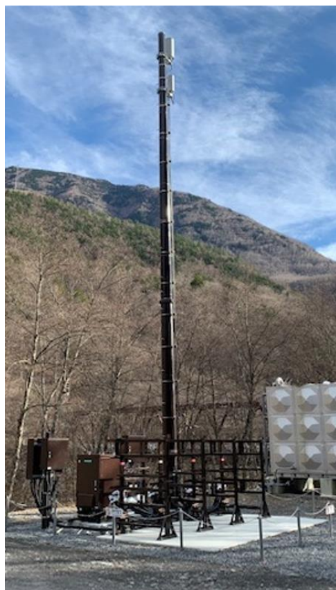
(写真) 静岡県の新設タワー
