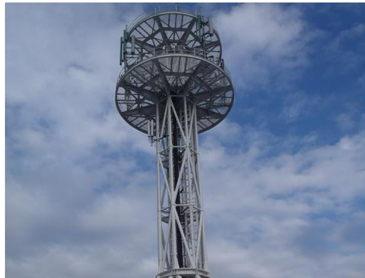
* 通信事業者等からの鉄塔の譲渡
